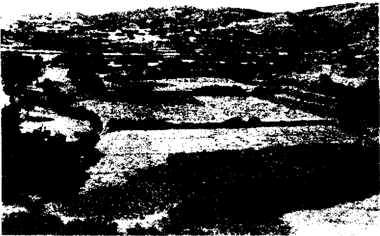
٧ - ٢ نموذج آخر للمدرجات المروية التي بنيت عبر روافد الأودية بالسراة
