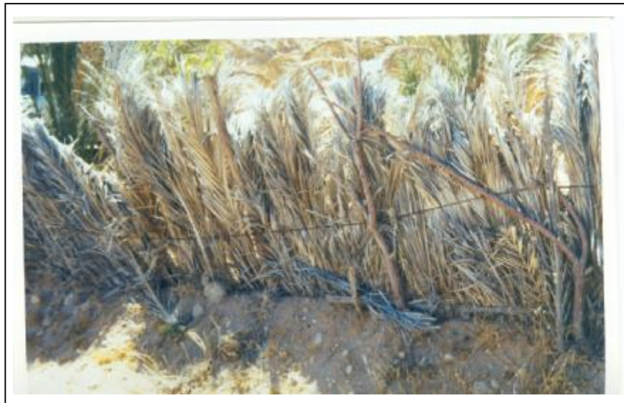
صورة رقم (29) تثبيت سعف النخيل في منطقة بوشقرون
