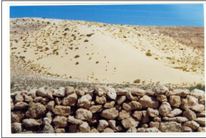
صورة رقم ( 30 ) التثبيت باستعمال حواجز الحجارة منطقة الحاجب
